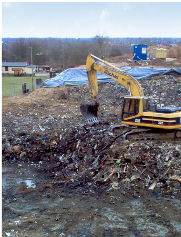
Abb. 3: Sanierungsarbeiten auf der Altdeponie Bruchköbel
